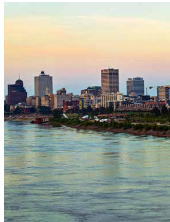
Die Abwasser- aufbereitung ist eine besondere Herausforderung für die Stadt Memphis, da das Abwasser größtenteils aus der Industrie stammt.
