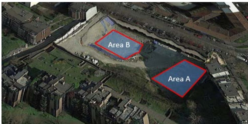
Figura 1. Visione d'insieme del sito e delle aree di trattamento
